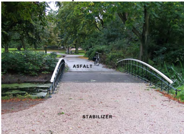
Plan: Stabilizer als halfverharding zorgt voor natuurlijke uitstraling
